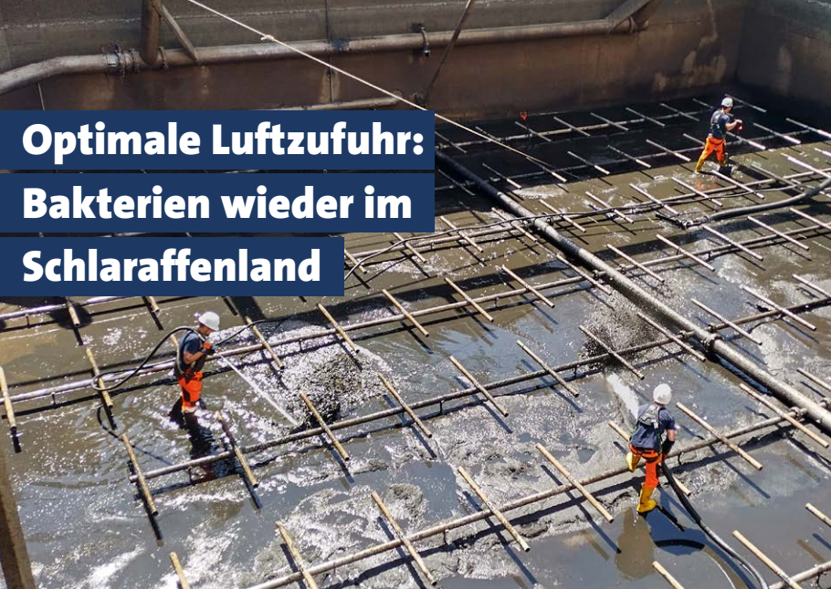
Mitarbeiter von Veolia reinigen eines der Klärbecken und haben neue Belüfterelemente eingebaut.
